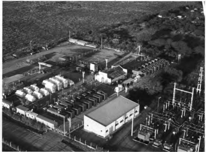
Empresas privadas participaron en el proyecto de construcción y operación de usinas termoeléctricas de Enarsa. Las nuevas usinas aportaron energía al Sistema Interconectado Nacional (SIN). En la imagen, la subestación Charata, en la provincia de Chaco, inaugurada en 2008.
